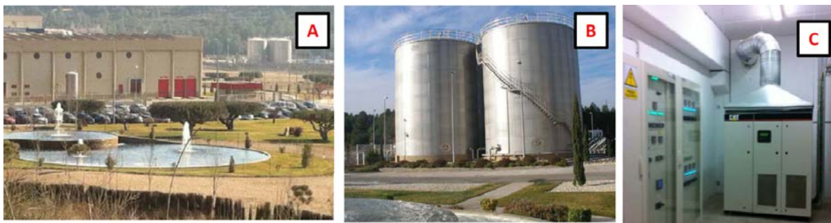
Figura 7: A) Detalle de lago artificial: misión mejora depuración, ornamental y aprovechamiento para riego. B) Detalle de depósitos de almacenamiento de aguas pluviales. C) Detalle de sistema de alimentación ininterrumpida dinámica. Fuente: Elaboración propia.
